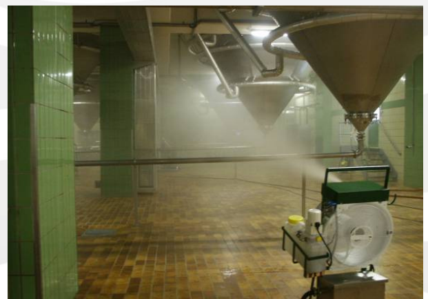
Schimmelbekämpfung in einer Brauerei
