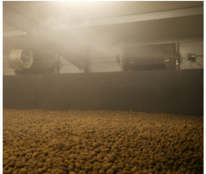
Luftbefeuchtung in einem Kartoffel-Schüttlager
